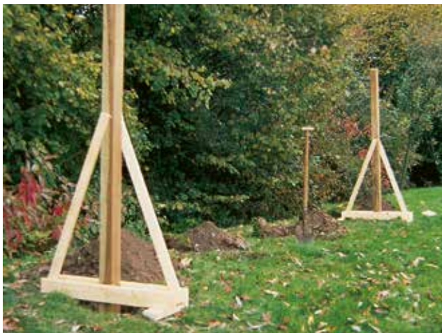
Montagehilfe zur Ausrichtung von Sichtblenden-Modulen
