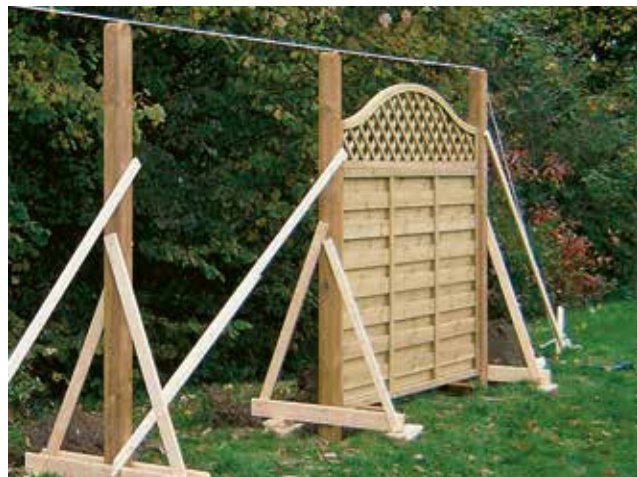
Die genaue Längsausrichtung klappt mit einer Spannschnur.
