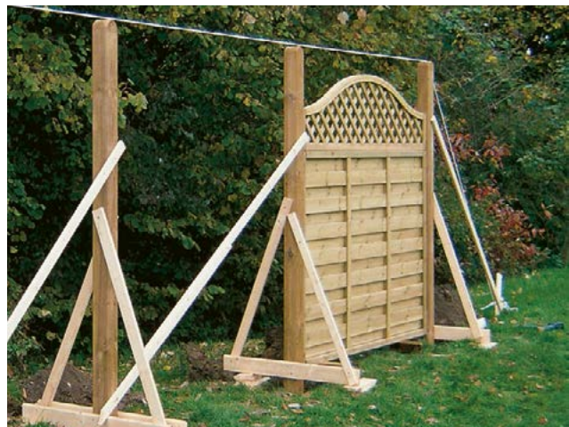
Die genaue Längsausrichtung klappt mit einer Spannschnur.
