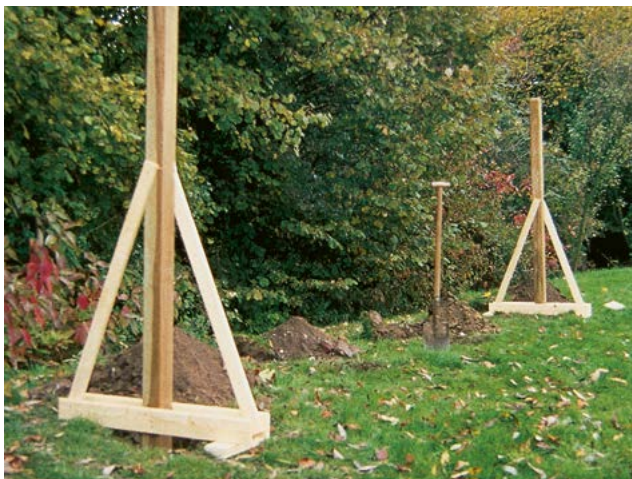
Montagehilfe zur Ausrichtung von Sichtblenden-Modulen
