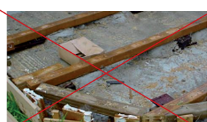
Dehnungsfugen von 10 mm zwischen den Dielen einhalten!
