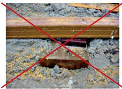
Die Unterkonstruktion nicht einbetonieren!
