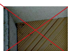
Dehnungsfugen von 5 mm zwischen den einzelnen Dielen und von 15 mm zu einer Mauer oder einem Hindernis einhalten!
