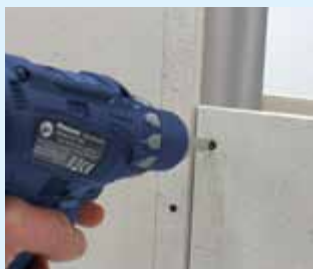
Schrauben auf Metall-Unterkonstruktion
