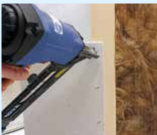
Klammern auf Holz-Unterkonstruktion
