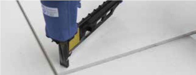
Knauf Gipsfaserplatten-Doppelbeplankung mit Spreizklammerbefestigung (unterkonstruktionsneutral). Stossfugenversatz \geq 200 mm
