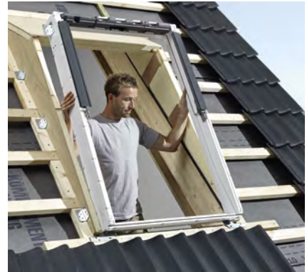
3. Fenster-Blendrahmen in die Dämmung einsetzen und verschrauben.
